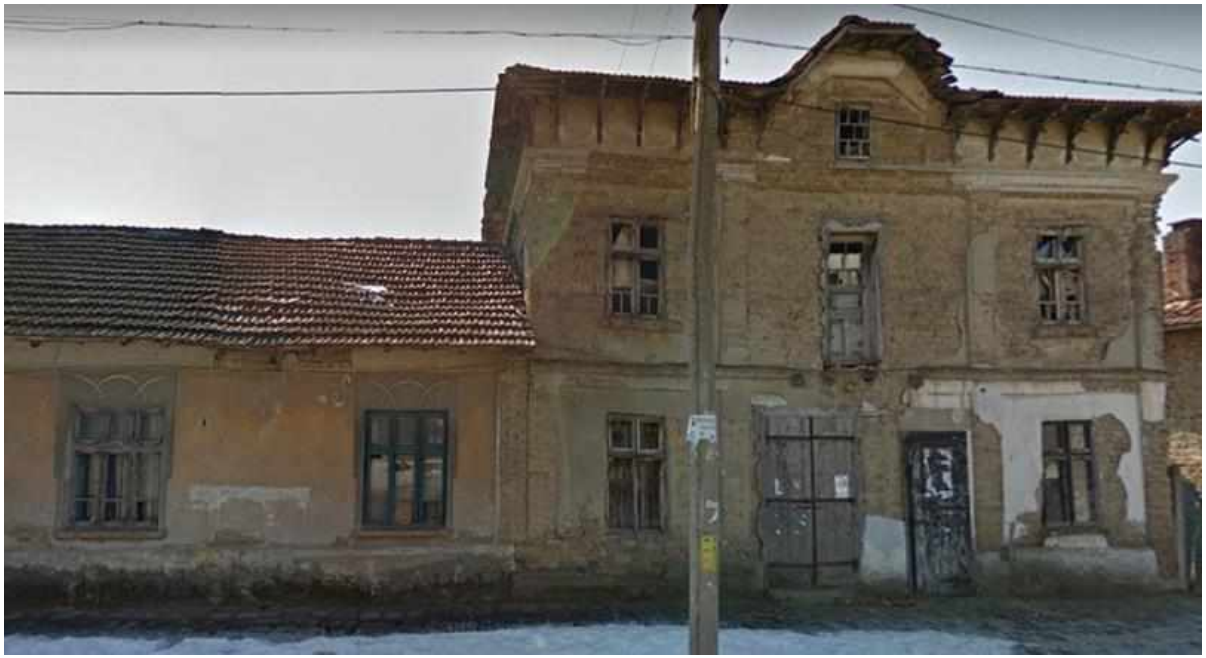
Фиг. 41 Състояние на сградния фонд – с. Гиген, сн. Google Streetview, 2012
