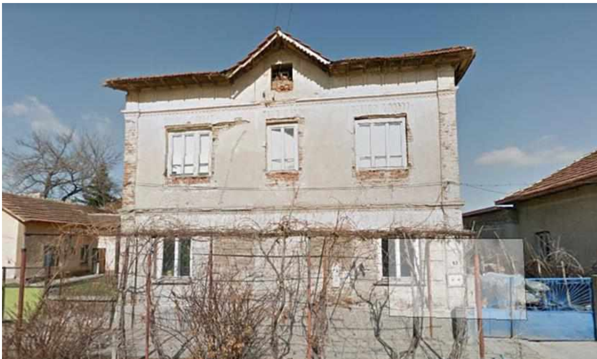
Фиг. 40 Състояние на сградния фонд – с. Гиген, сн. Google Streetview, 2012
